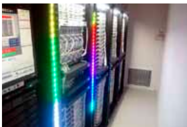
キーボード/タッチパッドパネルを収納し LCD パネルだけで表示(手前ラック上部)。 ラック前方の空間が有効活用できる
