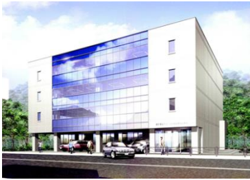
株式会社東計電算第1データセンター
