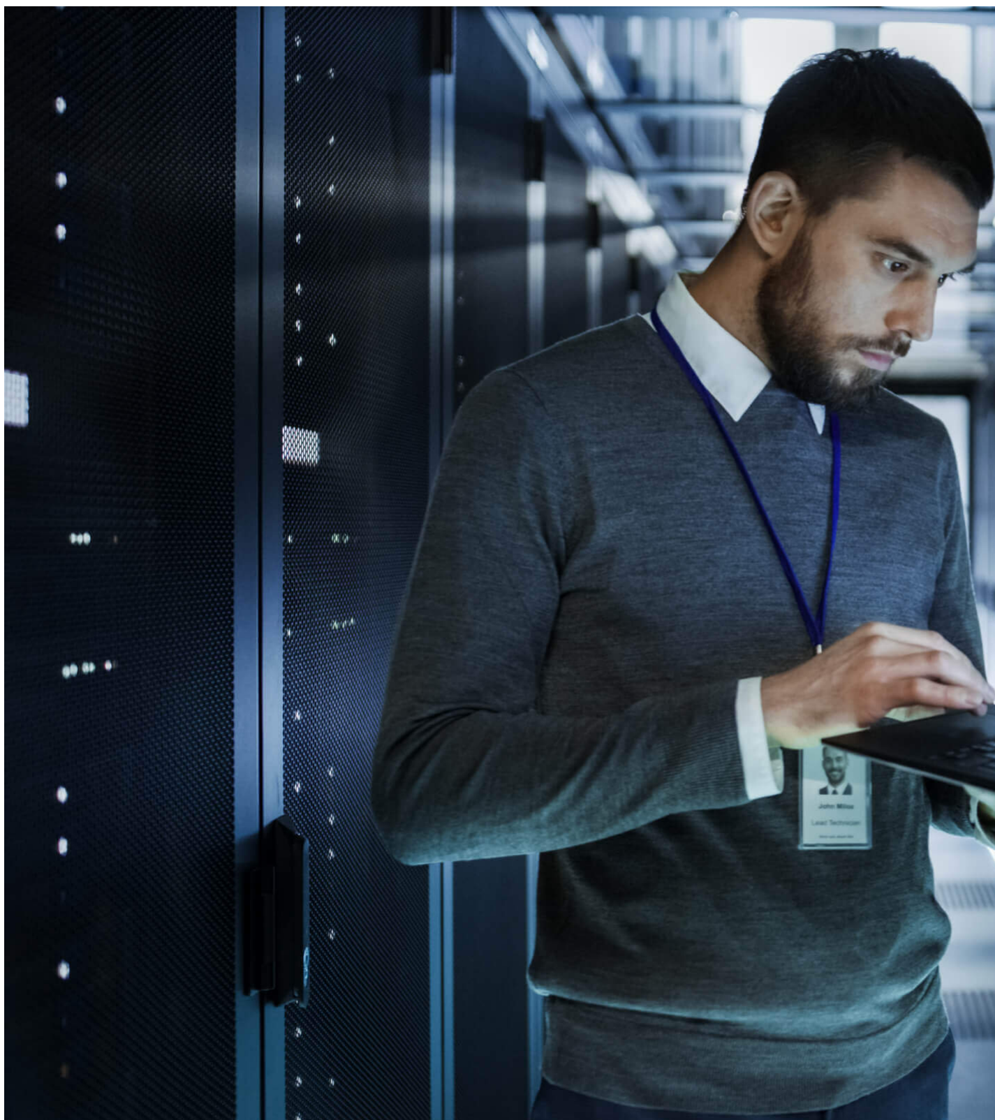
Sala de servidores
